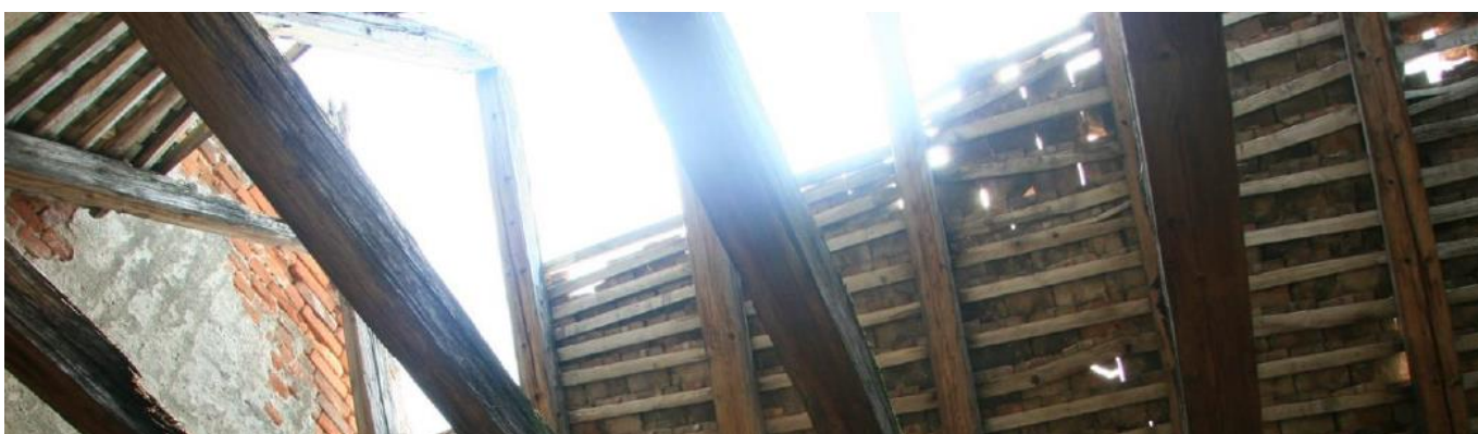
Obr. 3.: Keramická krytina v dezolátnom stave - interiér (Zdroj: Vladimír Kohút, Lukáš Kramarčík)
