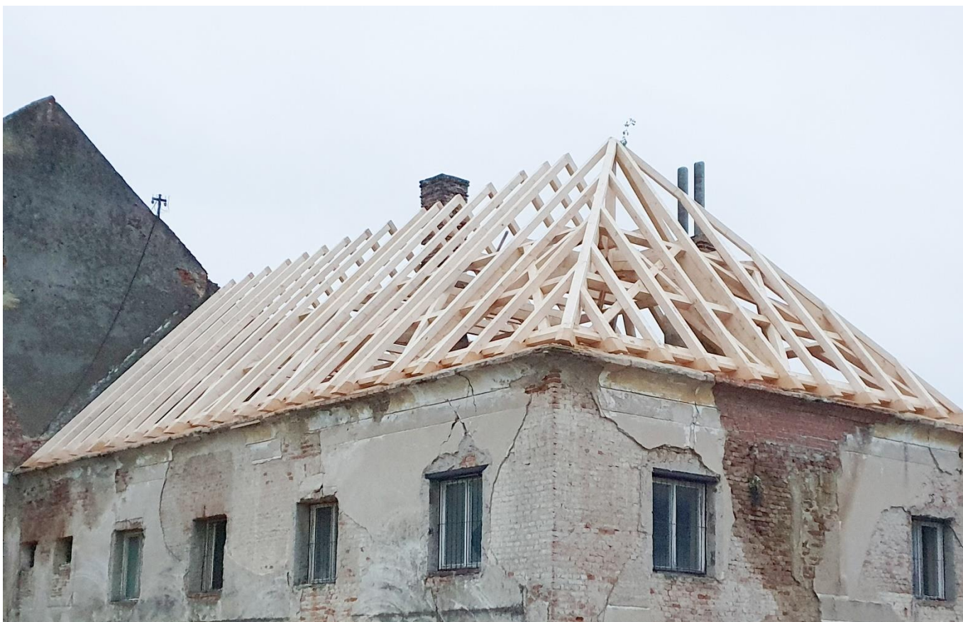
Obr. 7.: Zrealizovaná nosná časť krovu (Zdroj: Zdeno Krump)
