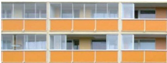
Obr. 2 Komplexná obnova s jednotným dizajnom zasklievania fasády bytového panelového domu (Zdroj: www.zamre.sk, 2020)
