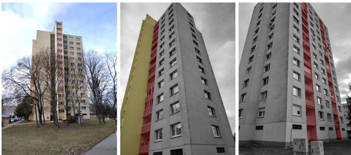
Obrázok 159 Existujúci stav bytového domu typu ZTB – 13 B. Červenou sú označené polohy loggií e a žltou schodisko uvažované ako nárazníková zóna (Zdroj: Kasala, Ruhig, 2019)
