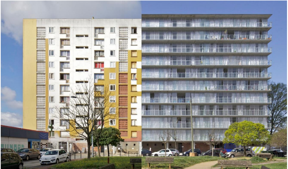
Obrázok 65 Pred a po vyhotovení prístavby v podobne zimnej záhrady na celú plochu bytového domu (Zdroj: www.archinfo.sk , 2020)
