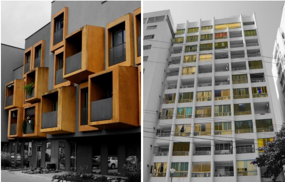
Obrázok 117 Visuté loggie na fasáde bytového domu v Ljubljane (Enota), Slovinsko, 2007, (Zdroj: Kiabová, 2015)
