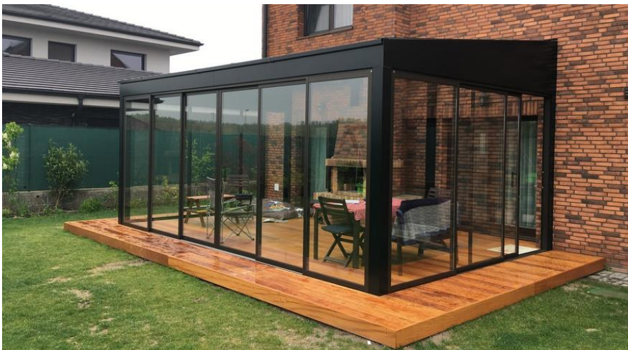
Obrázok 52 Zimná záhrada z hliníkových profilov, aditívne prístavaná k rodinnému domu, (Zdroj: www.almonsro.sk , 2020)
