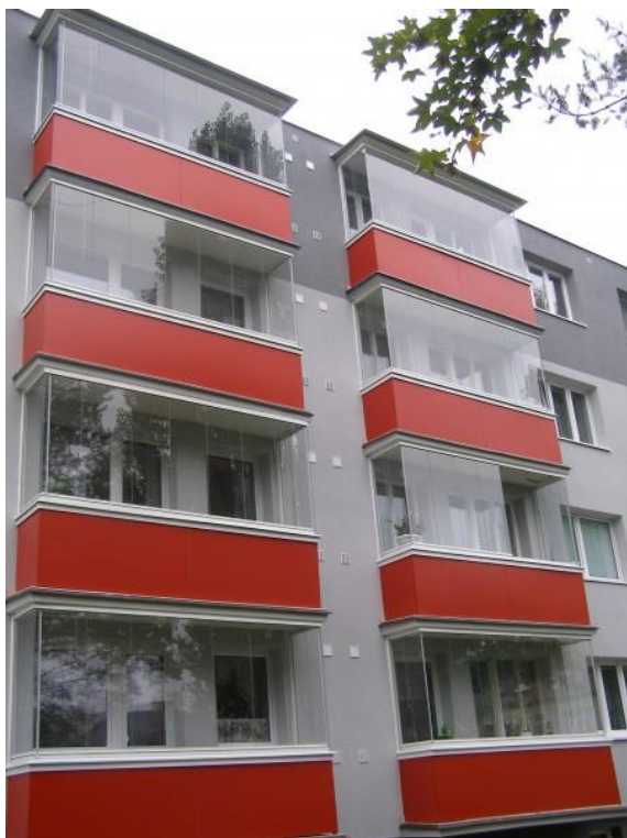
Obrázok 64 Zasklenie balkónov bezrámovým systémom – posuvný systém, bytového panelového domu, Trenčín, (Zdroj: www.vtr.sk , 2018)
